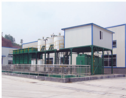
污水处理系统 Sewage Disposal System
